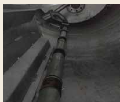
MÉLANGEUR PNEUMATIQUE POUR ÉVITER LA SÉDIMENTATION
